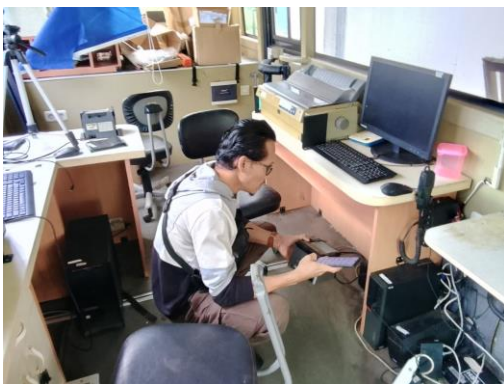
(Membersihkan dan melakukan pengecekan pada setiap port switch/hub)
